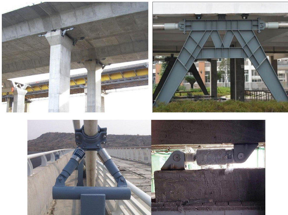
میراگر ویسکوز مایع نصب شده در ساختمان- میراگر ویسکوز مایع نصب شده در پل
