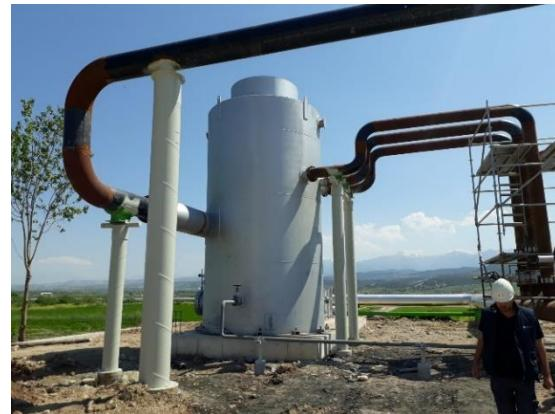
این تجهیز می‌تواند به دو صورت inline و vent مورد استفاده قرار بگیرد. در حالت vent گاز یا بخار بعد از عبور از سایلنسر مستقیماً وارد اتمسفر می‌شود ولی در حالت inline سایلنسر در مسیر خط لوله قرار می‌گیرد. در هر دو حالت به صورت افقی و عمودی قابل استفاده است.
